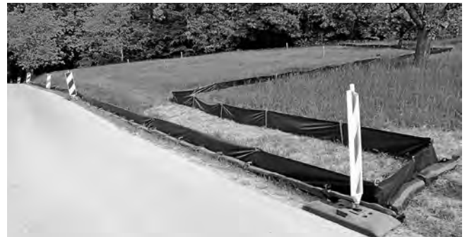
Geplantes Baufeld für den Neubau des Trinkwasserhochbehälters
